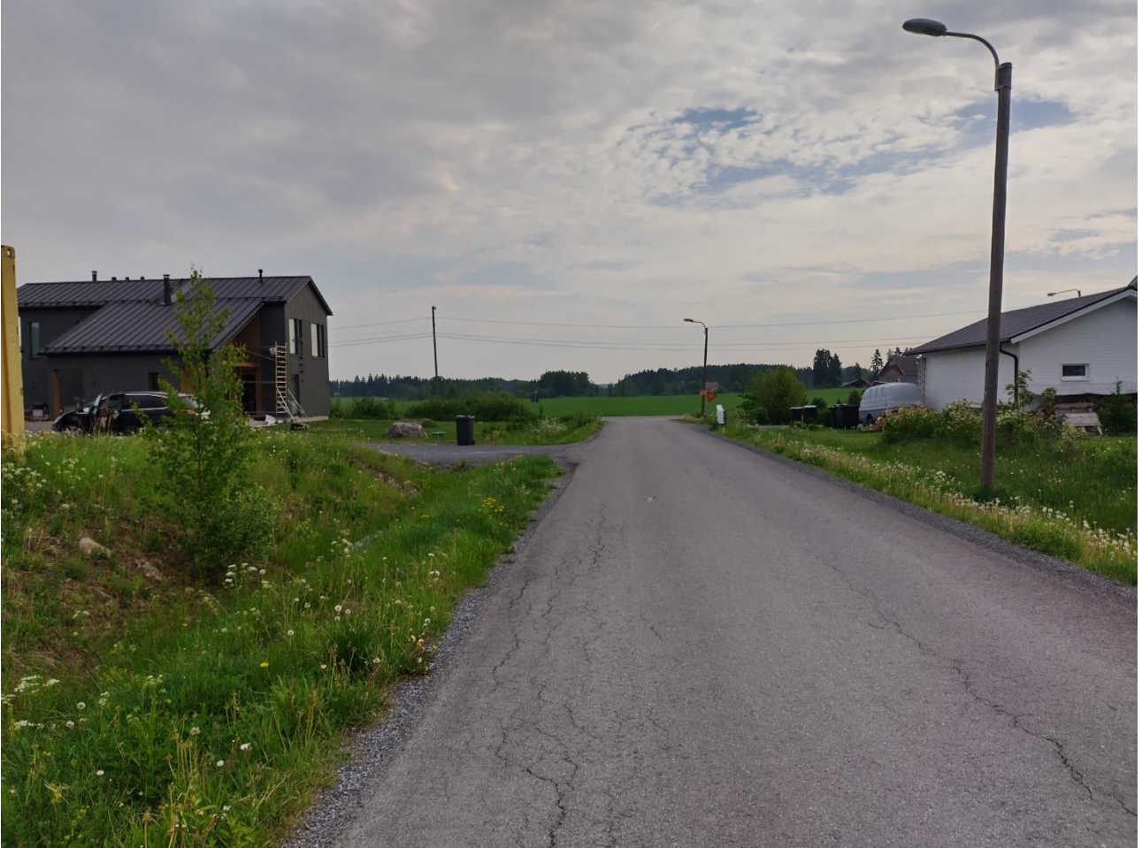
Kuva 4: Näkymä kaava-alueen laidalta pohjoiseen päin. Kuvassa Jyskäntietä aina Kaakilanmutkan risteykseen saakka, jonka takana Kaakilanniemen-Hietaniemen peltoaukeaa.
